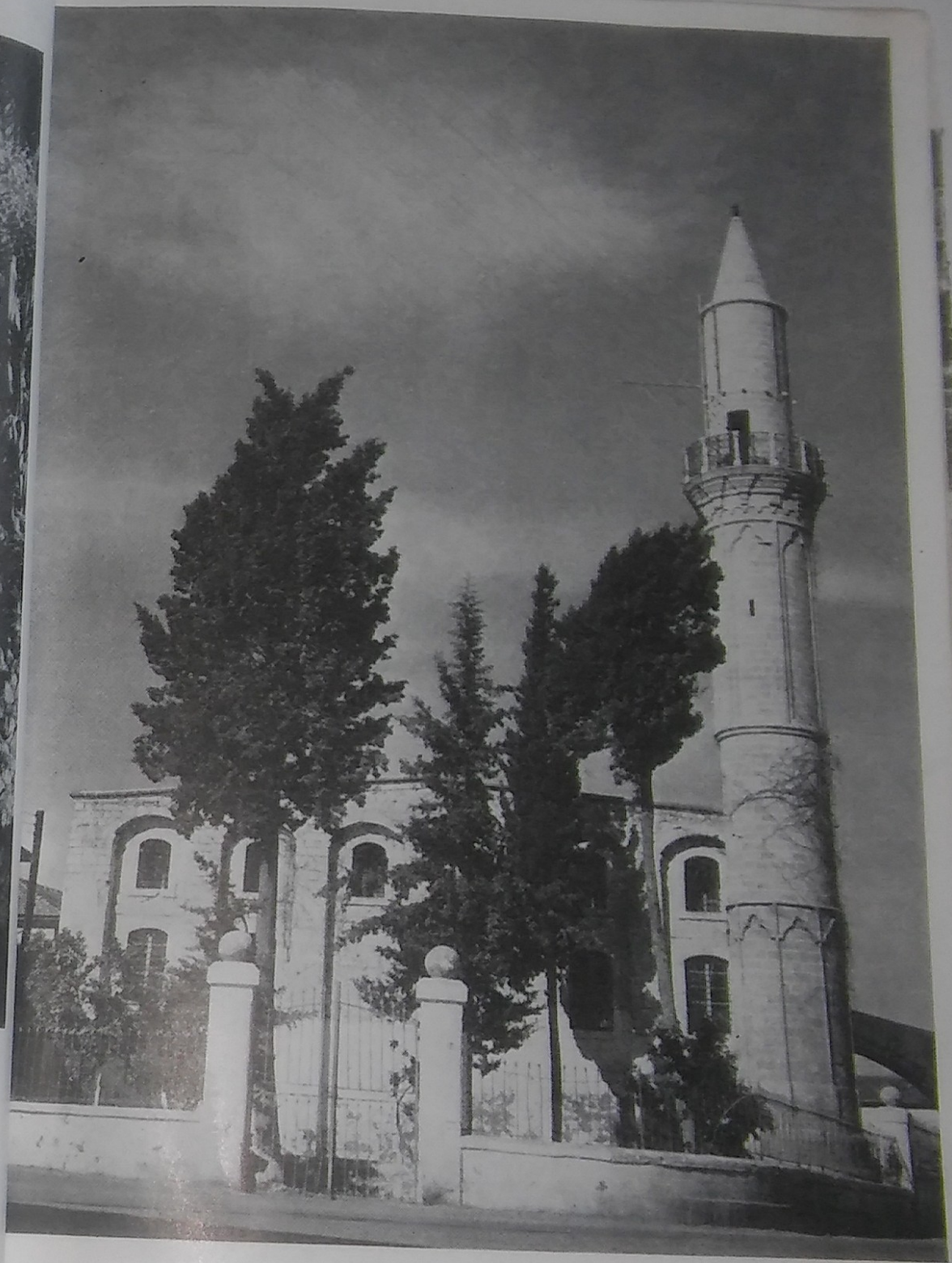
Lârnaka'da Bekir Paşa Camii
